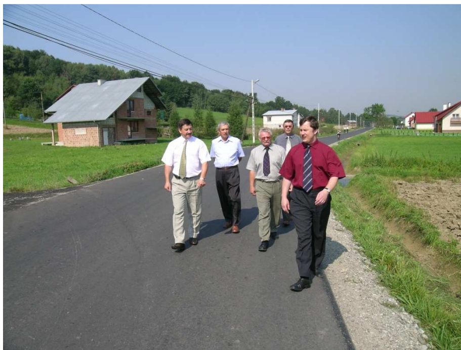
Fot. 30 – Odbiór zmodernizowanego odcinka drogi powiatowej Niebylec – Gwoźnica w miejscowości Konieczkowa. Inwestycja Powiatu Strzyżowskiego
