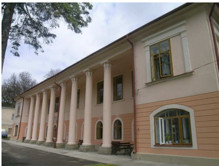
Fot. 45 - Żywnów. Odnowiona elewacja pałacu Bylickich, obecnie Domu Dziecka w ramach projektu ZPORR. Inwestycja Powiatu Strzyżowskiego
