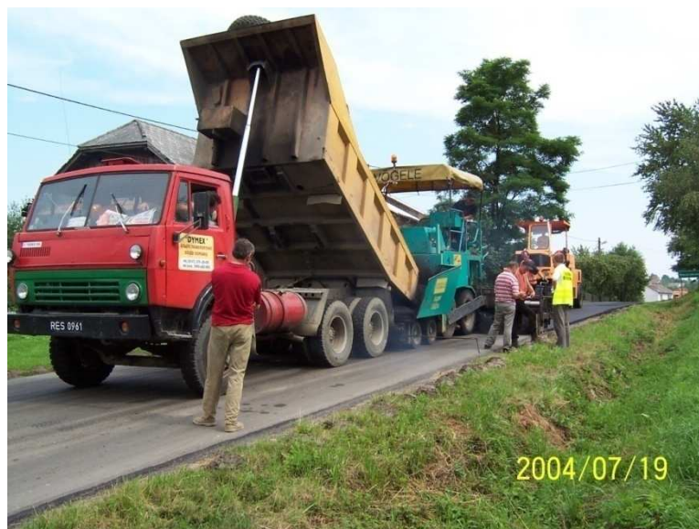
Fot. 43 - Konieczkowa. Modernizacja nawierzchni drogi powiatowej Niebylec – Gwoźnica. Projekt Powiatu Strzyżowskiego w ramach ZPORR
