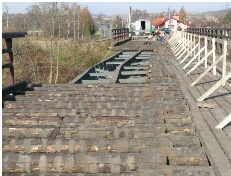
Fot. 31 - Dobrzechów. Most na rzece Wisłok w ciągu drogi powiatowej Dobrzechów – Wysoka Strzyżowska – Węglówka w trakcie odbudowy
