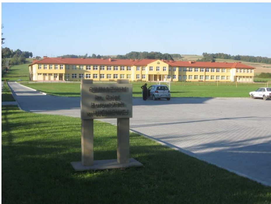
Fot. 21 - Wiśniowa. Oddany do użytku w 2006 r. obiekt Gimnazjum Publicznego im. Orłąt Lwowskich. Inwestycja Gminy Wiśniowa
