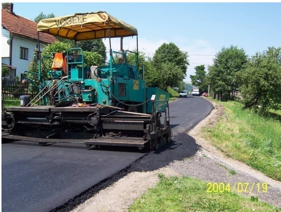
Fot. 9 - Nowa Wieś. Modernizacja nawierzchni drogi powiatowej
