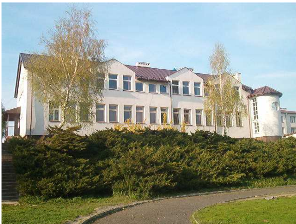
Fot. 20 - Frysztak. Obiekty Specjalnego Ośrodka Szkolno – Wychowawczego po modernizacji. Inwestycja Powiatu Strzyżowskiego
