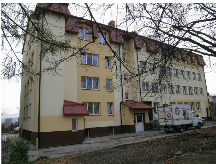
Fot. 41 - Strzyżów. Oddany do użytku w 2006 r. rozbudowany obiekt Specjalnego Ośrodka Szkolno – Wychowawczego. Inwestycja Powiatu Strzyżowskiego
