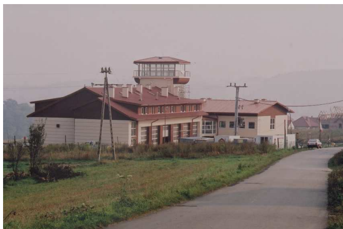
Nowa siedziba Państwowej Straży Pożarnej w Strzyżowie – etap budowy
