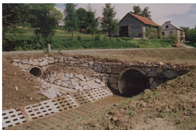
Odbudowany fragment infrastruktury drogi powiatowej w Niewodnej
