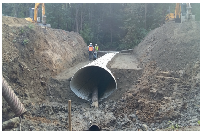
Przebudowa drogi powiatowej nr 1931R Żarnowa–Niebylec w miejscowości Gwoździanka. Wartość inwestycji: 1 040 778,74 zł. Okres realizacji: 2016 r.
