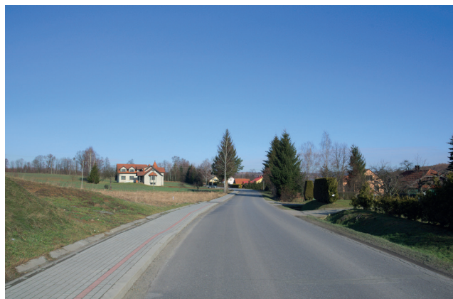
Budowa chodnika w ciągu drogi powiatowej nr 1927R Dobrzechów–Wysoka Strzyżowska–Węglówka. Wartość: 179 648,27 zł
