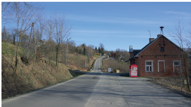
Przebudowa drogi powiatowej nr 1413R Niebylec–Blizianka–Sołonka w miejscowości Blizianka wraz z przebudową przepustów. Wartość: 718 818,15 zł
