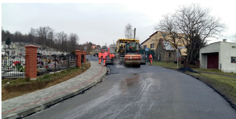
Przebudowa drogi powiatowej nr 1409R Zwiężczyca-Niechobrz-Czudec w miejscowościach Czudec i Przedmieście Czudeckie. Wartość: 1 593 741,58 zł
