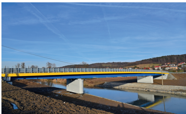
Przebudowa mostu drogowego w ciągu drogi powiatowej nr 1930R Żarnowa–Glinik Zaborowski w miejscowości Zaborów. Wartość: 5 735 560,36 zł. Okres realizacji: 2017 r.
