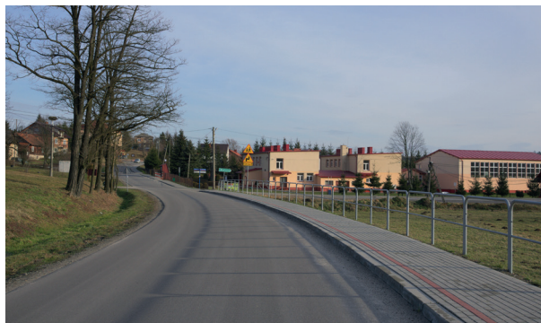
Przebudowa drogi powiatowej nr 1350R Różanka–Grodzisko w miejscowości Różanka. Wartość: 453 872,51 zł
