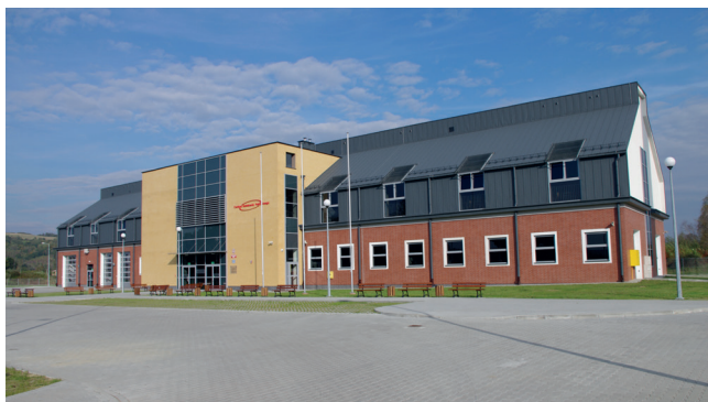
Główny budynek Centrum Kształcenia Praktycznego w Dobrzechowie. Wartość budowy oraz zakupu urządzeń i wyposażenia: 14 225 098,69 zł
