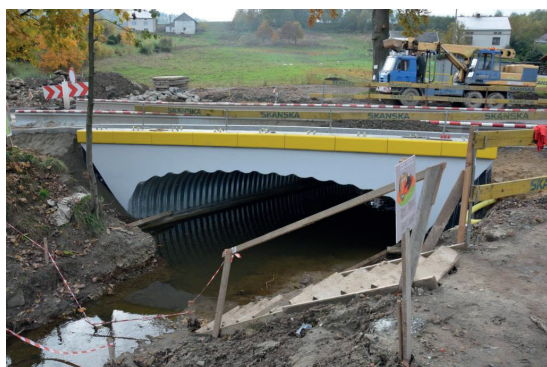
Przebudowa mostów w ciągu drogi powiatowej nr 1320R Cieszyna–Huta Gogołowska–Kamienica wraz z dojazdami. Wartość: 1 772 872,82 zł
