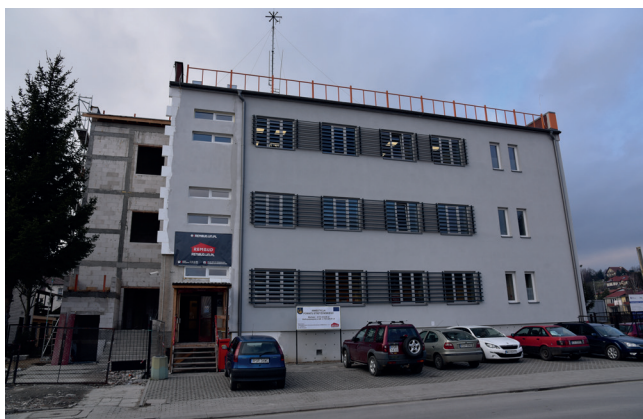
Przebudowa i rozbudowa budynku przy ul. Parkowej 7 w Strzyżowie na potrzeby jednostek samorządu powiatowego. Wartość inwestycji: 4 574 434,06 zł. Okres realizacji: 2017–2018
