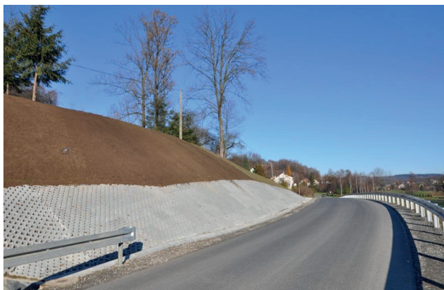
Zabezpieczenie i stabilizacja osuwiska wraz z odbudową odcinka drogi powiatowej nr 1930R Żarnowa–Glinik Zaborowski w miejscowości Żarnowa. Wartość: 3 258 814,89 zł
