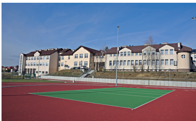
Przebudowa i rozbudowa przyszłolnego obiektu sportowego w celu przystosowania do wymogów boiska lekkoatletycznego typu „Orlik” przy Specjalnym Ośrodku Szkolno–Wychowawczym we Frysztaku. Wartość inwestycji: 2 563 361,34 zł. Okres realizacji: 2017–2018
