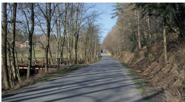
Przebudowa drogi powiatowej nr 1931R Żarnowa–Niebylec w miejscowości Gwoździanka. Wartość projektu: 1 044 778,74 zł
