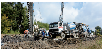
Likwidacja skutków osuwisk w powiecie strzyżowskim wraz z zabezpieczeniem in- frastruktury przed dalszym osuwaniem się ziemi na drogach Glinik Charzewski- Po- łomia, Pstrągowa – Nowa Wieś, Cieszyna Huta Gogolowska 3 888 400 zł
