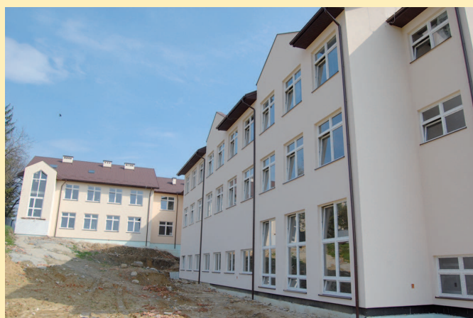
04.2013 – 06.2014 - rozbudowa Specjalnego Ośrodka Szkolno – Wychowawczego we Frysztaku – inwestycja samorządu powiatowego w Strzyżowie
