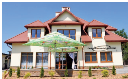
Budowa Centrum Kształcenia Praktycznego w Czudcu 1 401 998,14 zł
