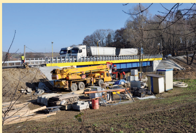
18.11.2013 r. – próba obciążeniowa nowego mostu na rzece Stobnica w Strzyżowie na drodze powiatowej prowadzącej na ulicę Modrzewiową – inwestycja samorządu powiatowego w Strzyżowie
