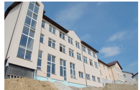
Budowa pawilonu dydaktyczno – rewalida- cyjnego w SOSW we Frysztaku dla kształ- cenia młodzieży w zawodach kucharz, cu- kiernik, stolarz, blacharz, ślusarz, murarz, betoniarz, zbrojarz, posadzkarz, malarz 3 983 893,03 zł
